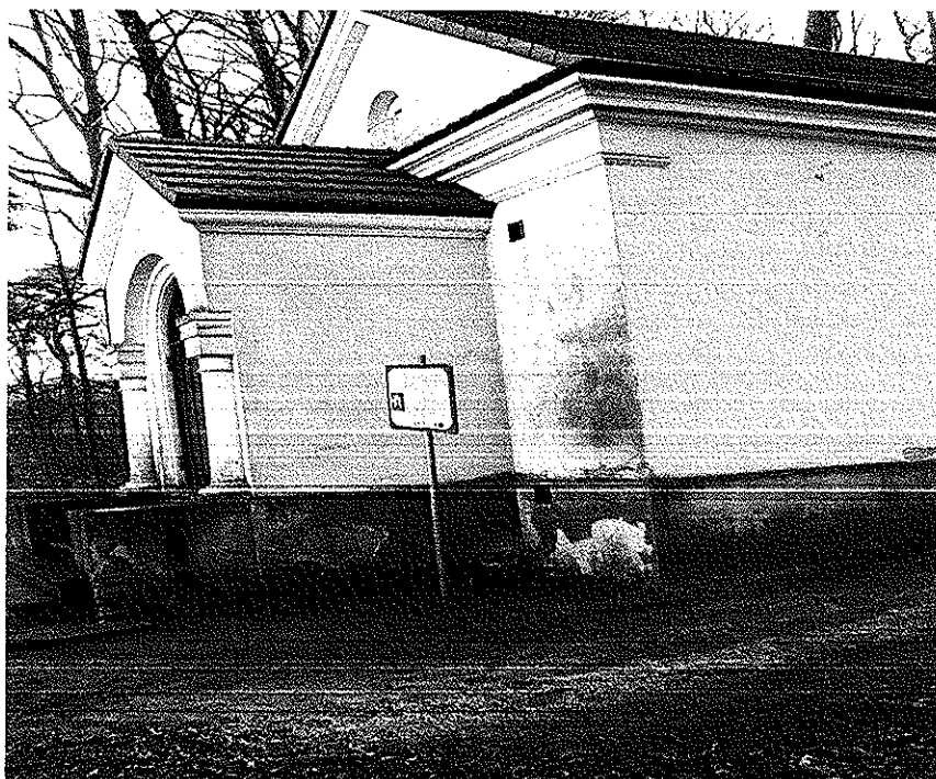
2. Elewacja południowo-zachodnia od strony jeziora
