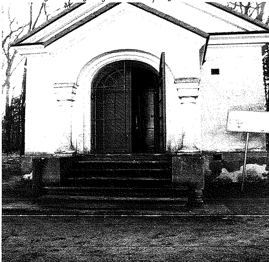
6. Schody betonowe wejściowe do kaplicy
