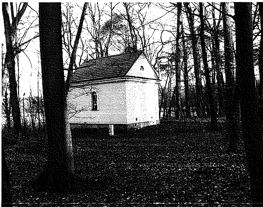
4. Elewacja południowa - widoczna część południowo-zachodnia i południowo-wschodnia
