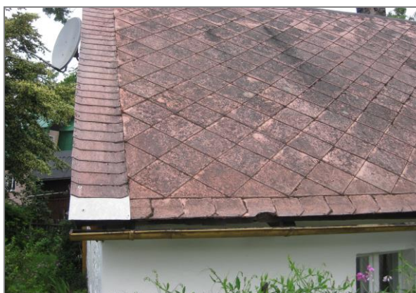
Fot. 2 Płyty azbestowo-cementowe płaskie
