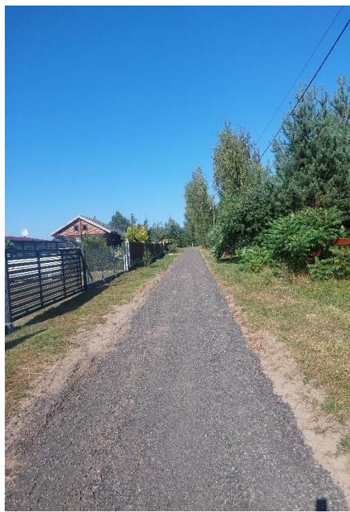
Droga w miejscowości Zaździerz
