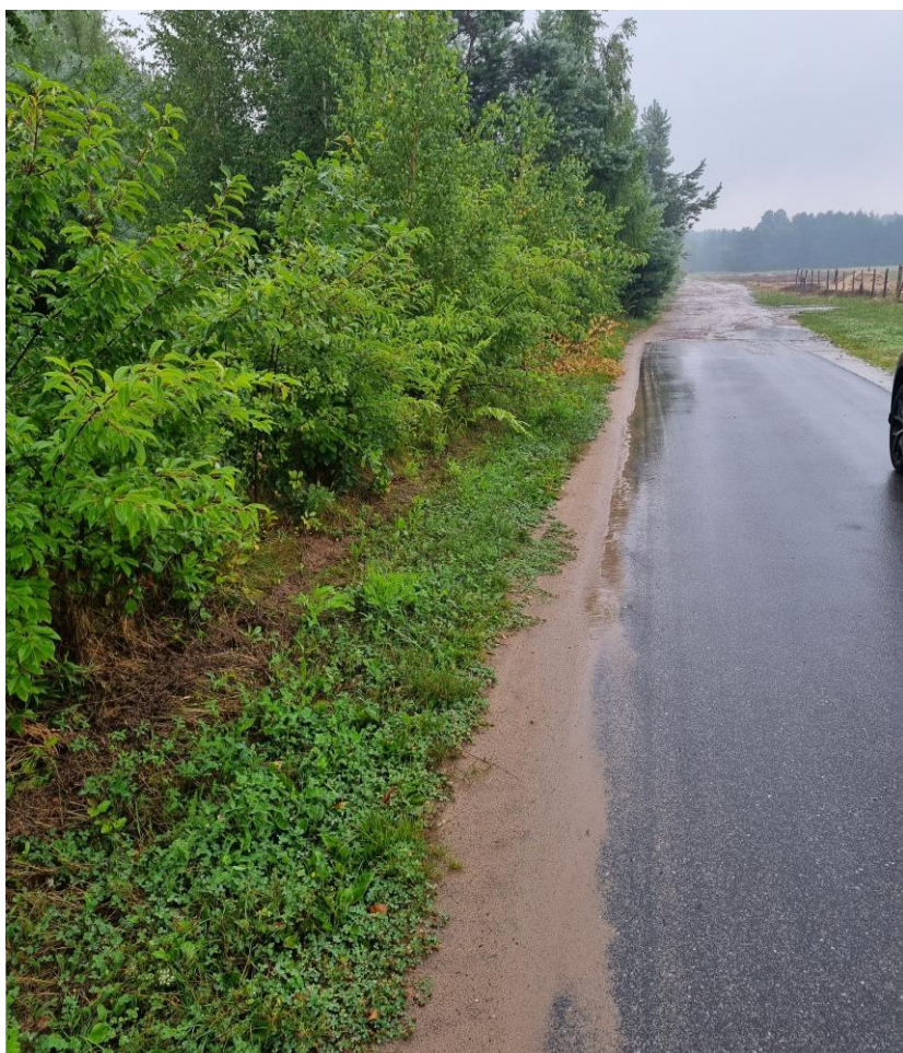
Po stronie lewej rów wykonany równiarką
